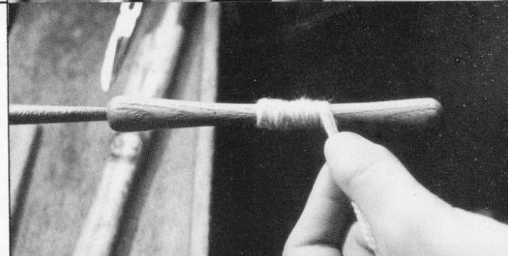
4/ Puis suite de l'enroulement en sens inverse, couvrant les deux centimètres existant déjà et les dépassant d'environ 1,5 centimètre.
